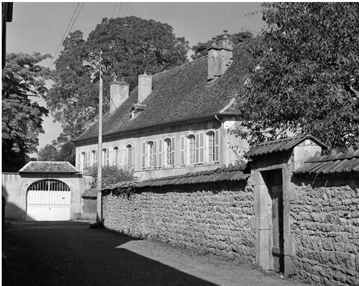
Demeure située 5 chemin de Vervaux.
