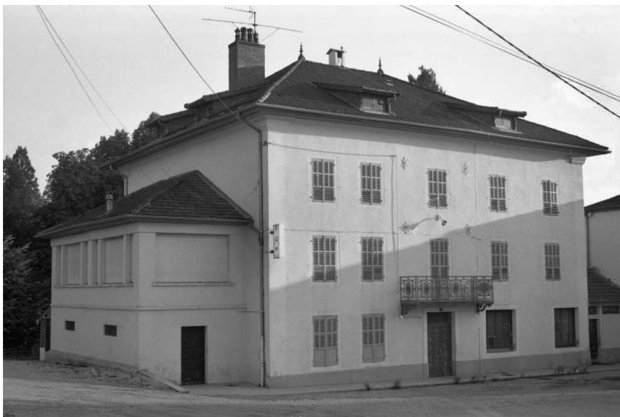
Logement patronal, de trois quarts gauche.
