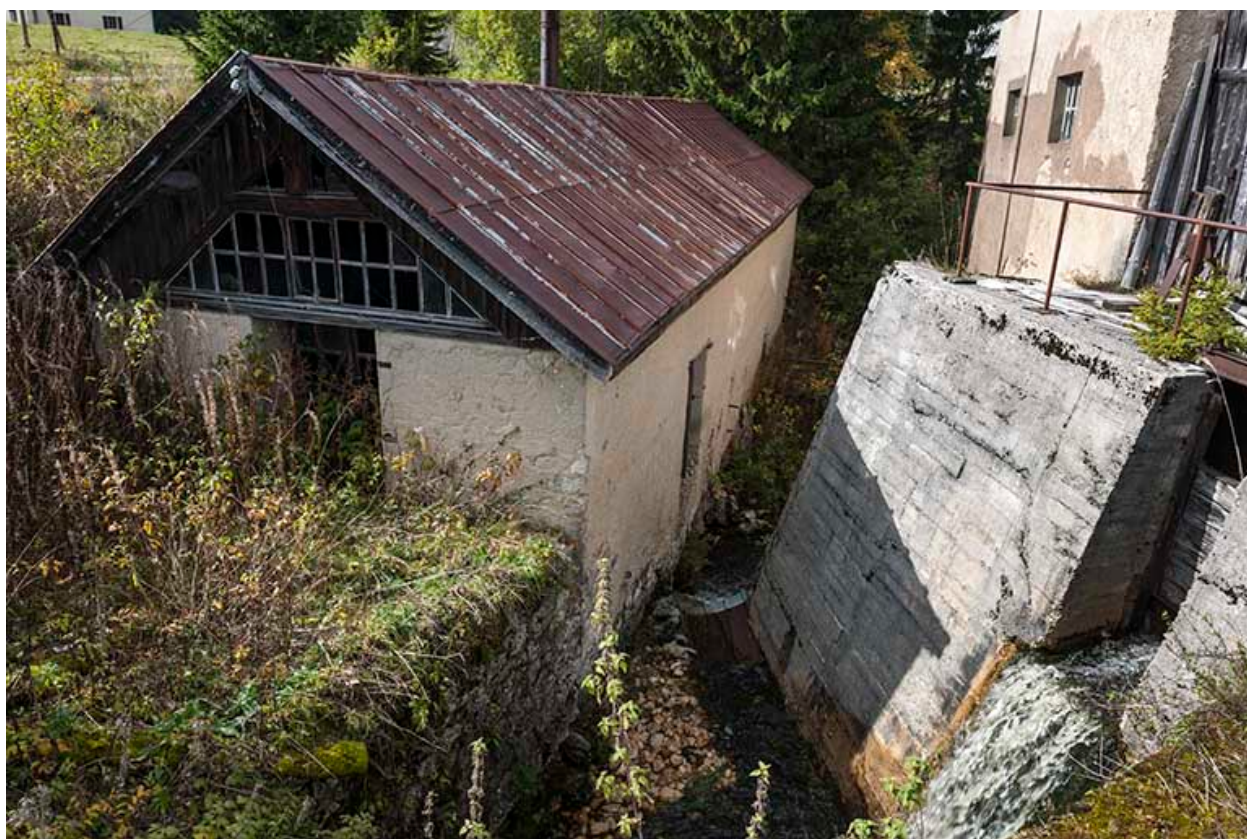
Salle de la machine à vapeur.
