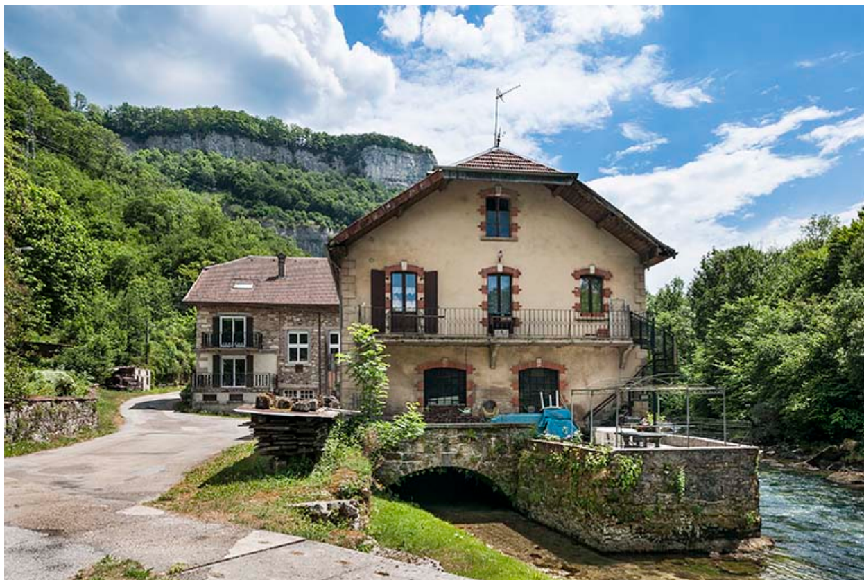
Vue rapprochée depuis l'ouest en 2015.
