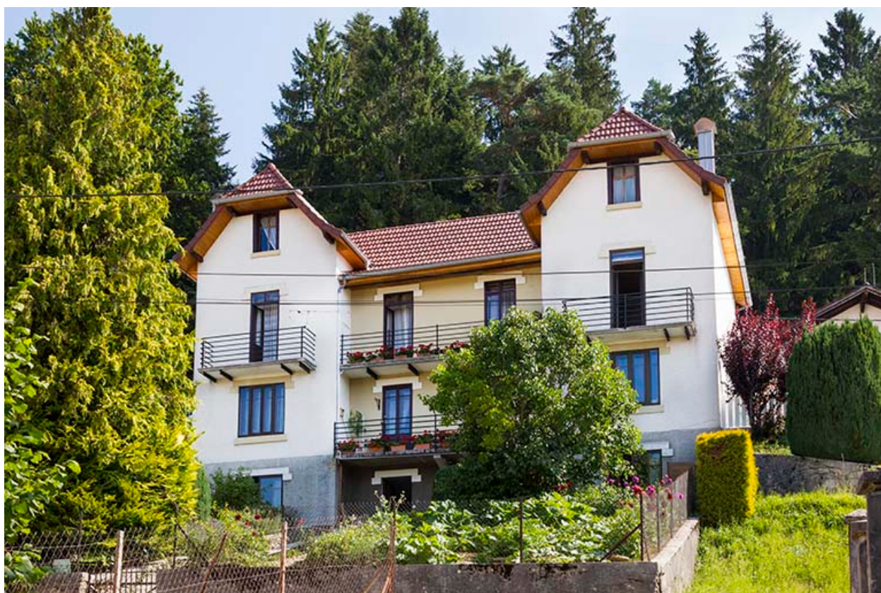
Immeuble n° 6 : façade côté vallée (ouest).
