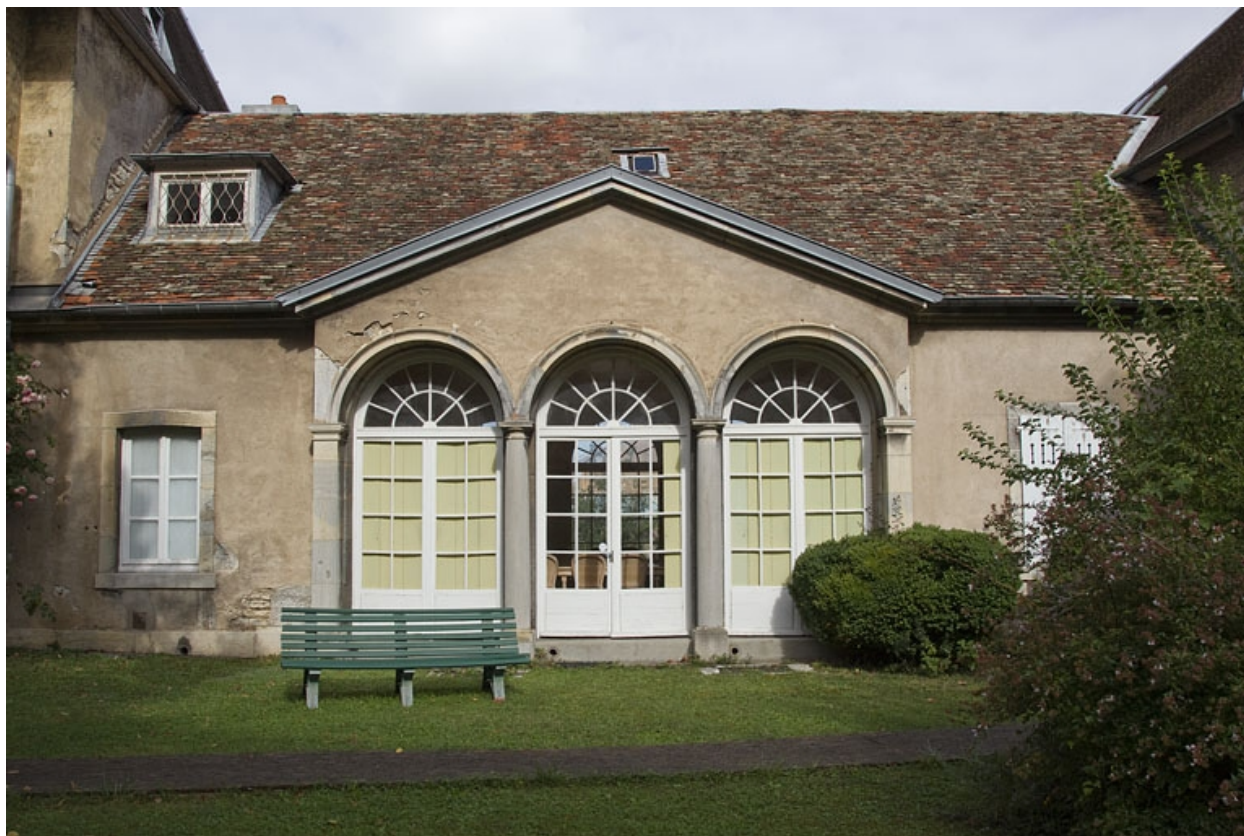
Orangerie : vue d'ensemble de la façade postérieure.
