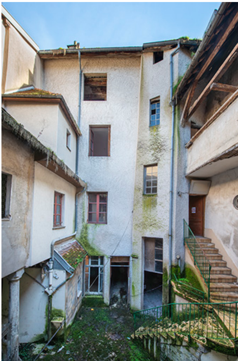
Vue d'ensemble depuis l'ouest de la cour.
