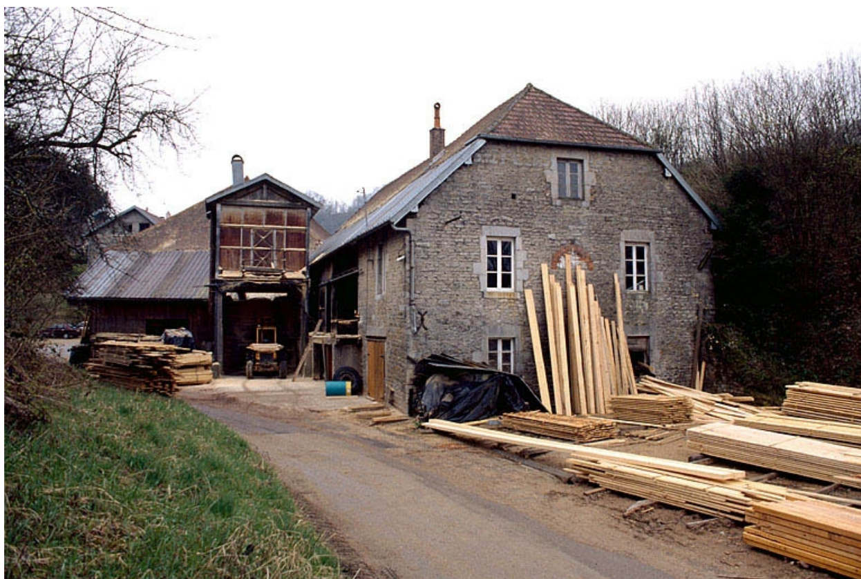
Atelier de fabrication nord.
