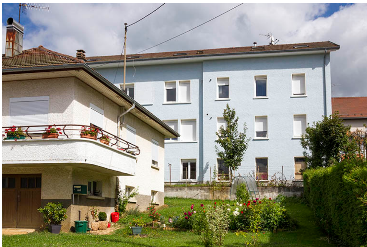
Façade postérieure (partie droite).
