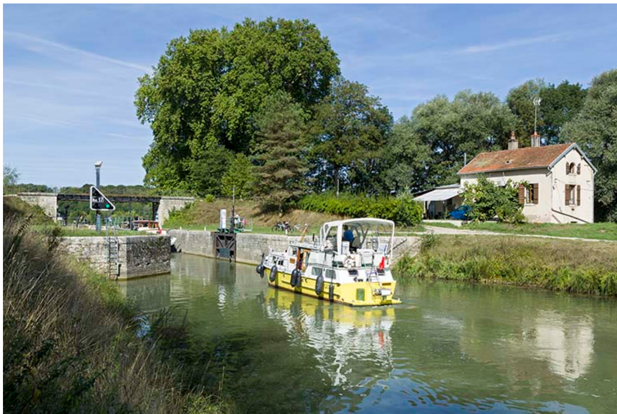
Vue générale depuis l'amont.
