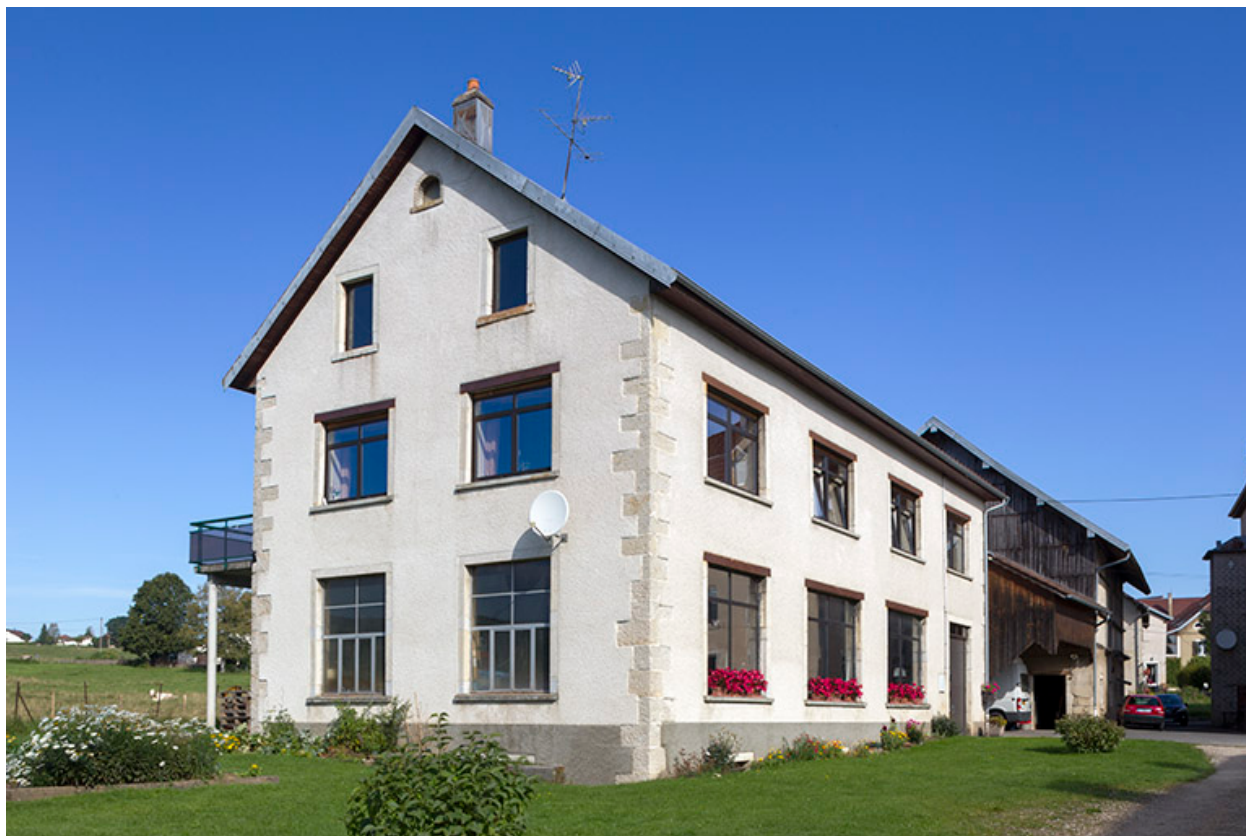
Ancienne fonderie : façades antérieure et latérale gauche.
