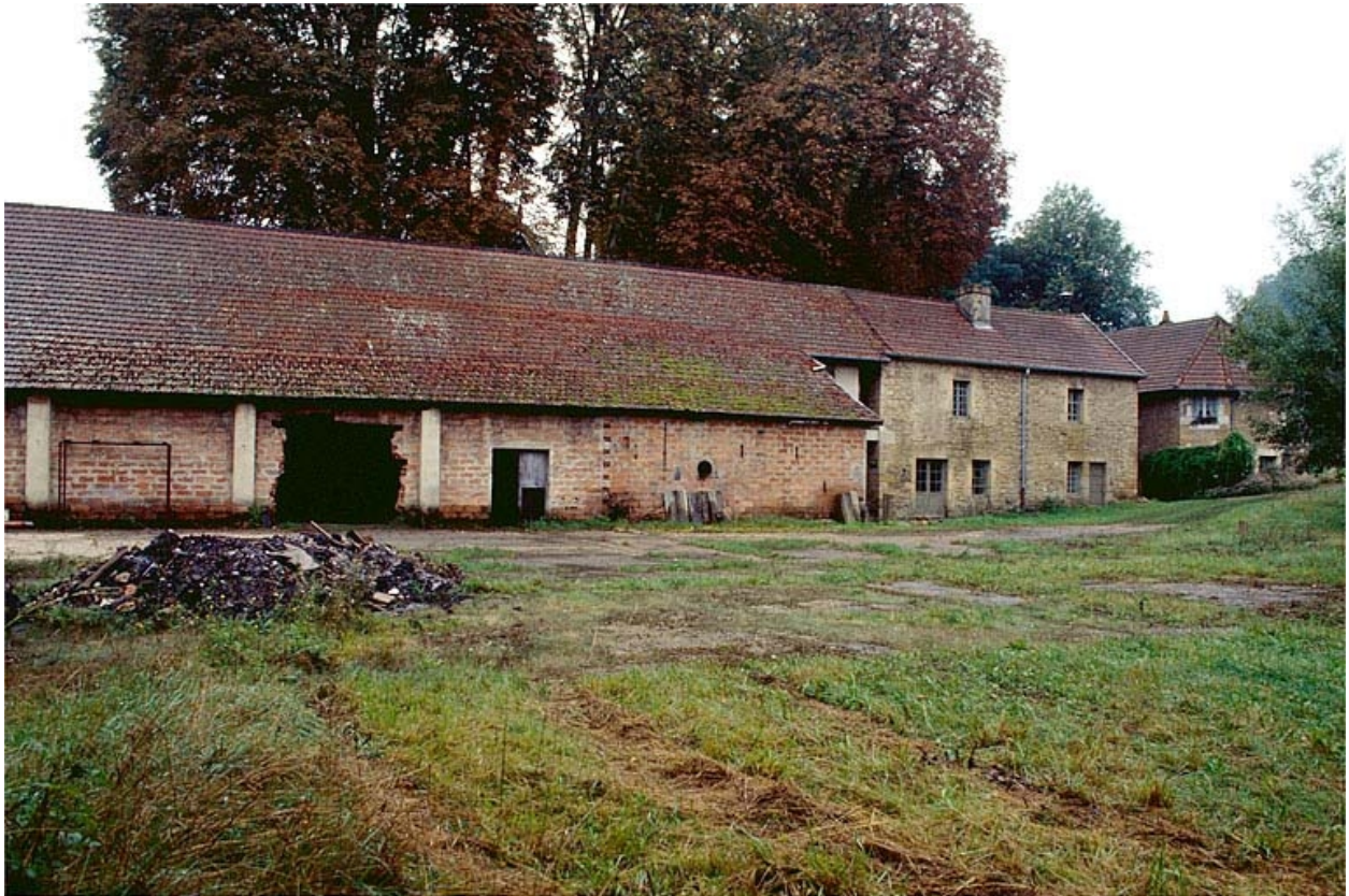
Atelier de fabrication (?), vu depuis le nord.
