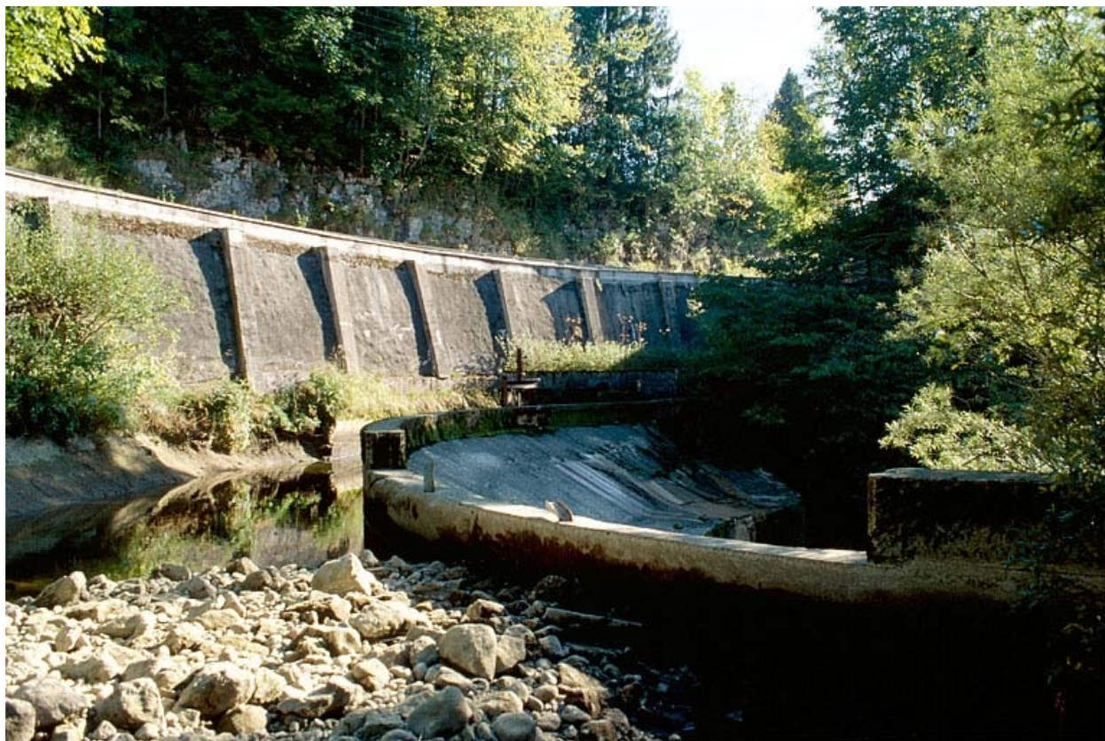
Canal d'amenée et déversoir du barrage.
