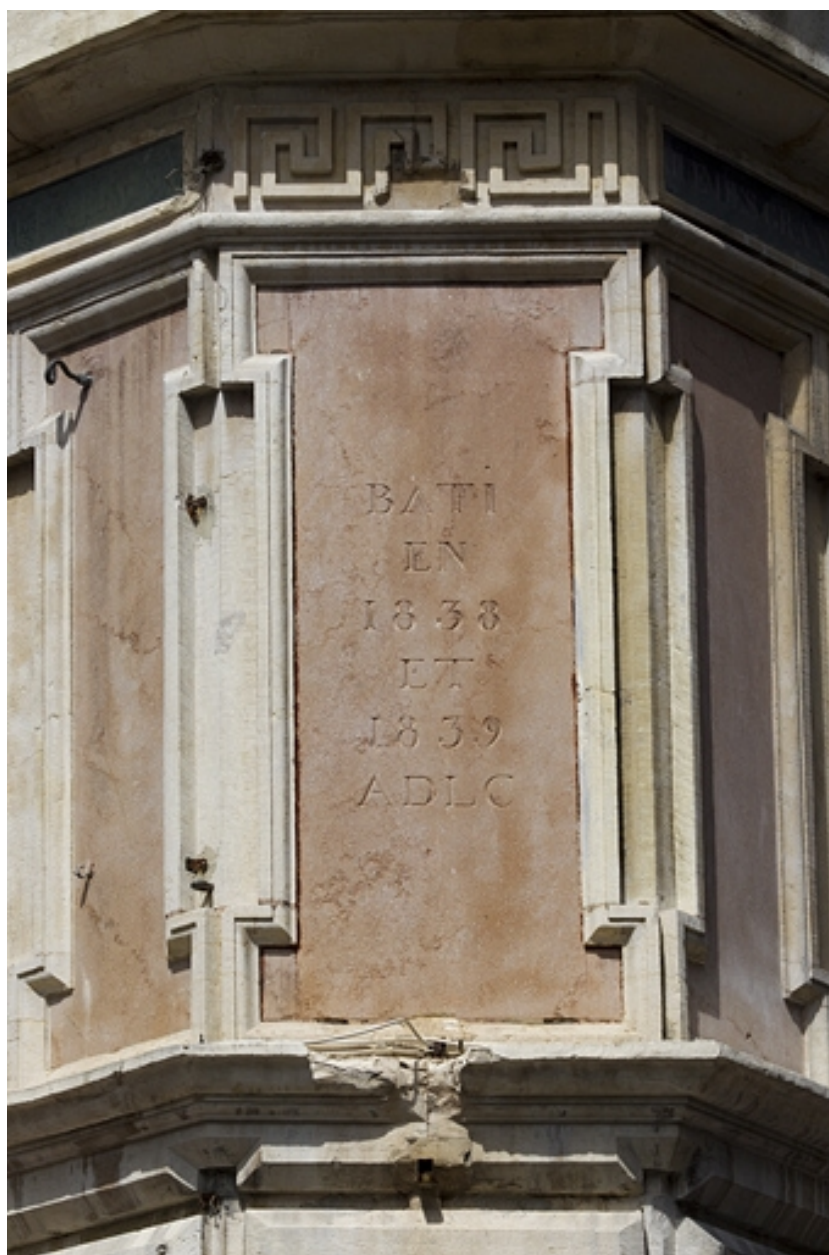
Angle du bâtiment : détail de l'inscription.
