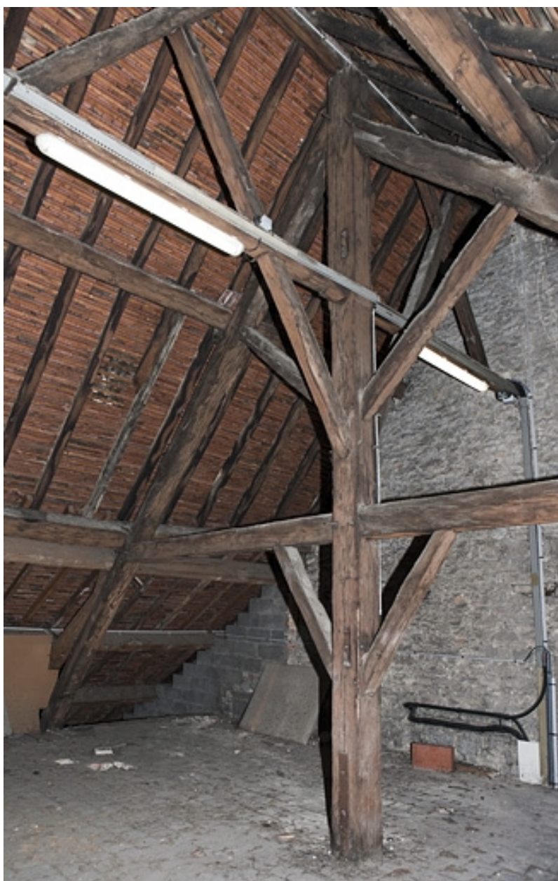
Intérieur, comble : détail de la charpente.
