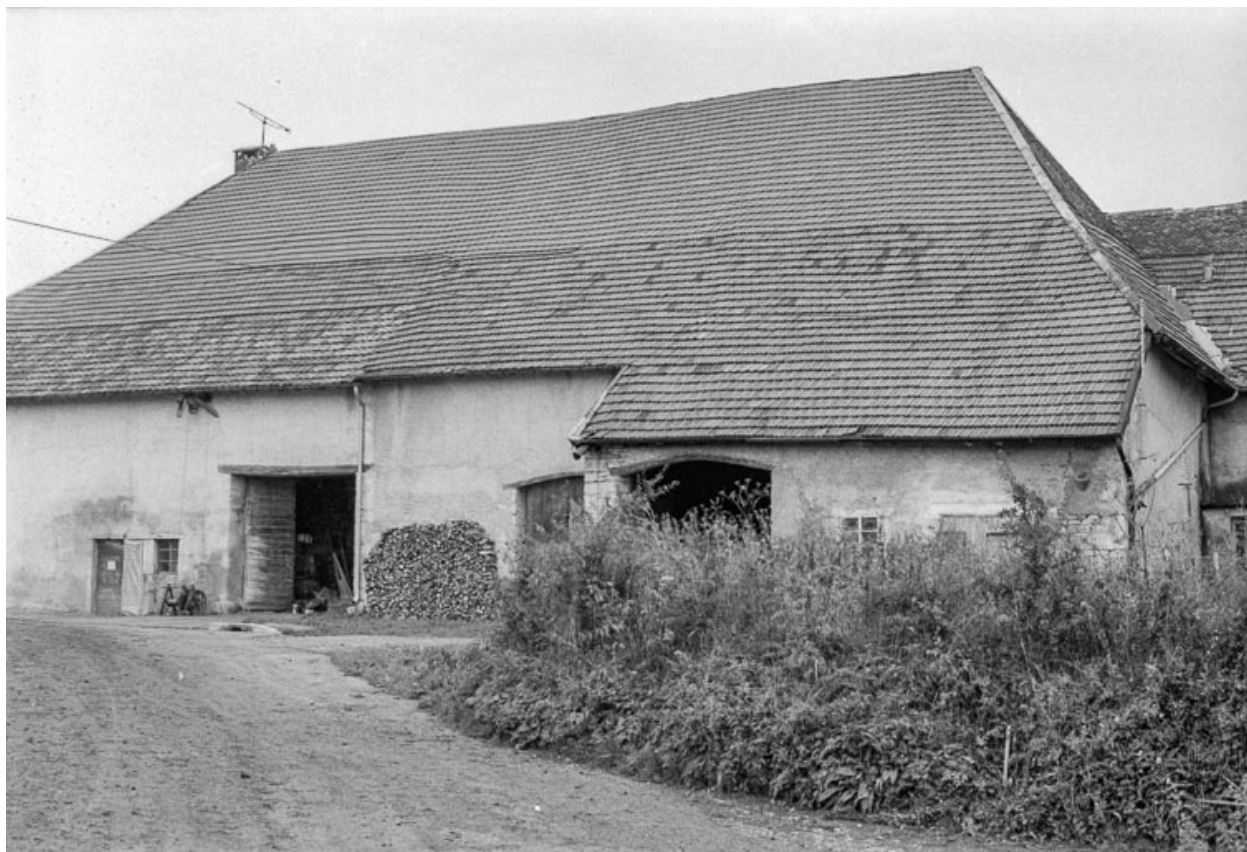
Ferme cadastrée 1939 F 2-3 : façade latérale droite.
