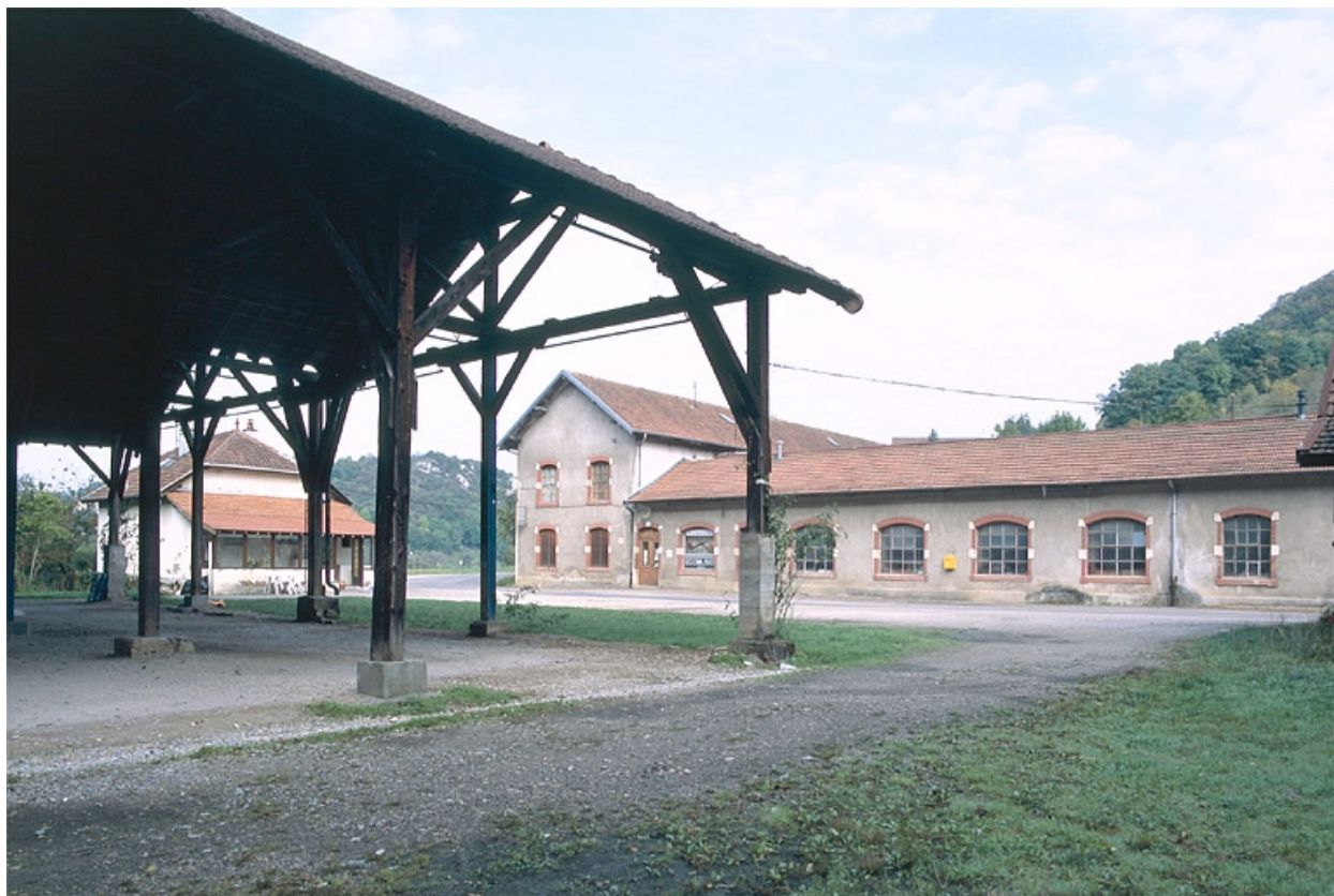
Façade antérieure depuis l'entrepôt à merisier.
