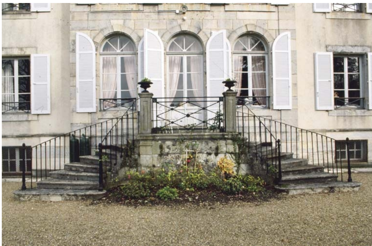
Détail de la façade ouest.
