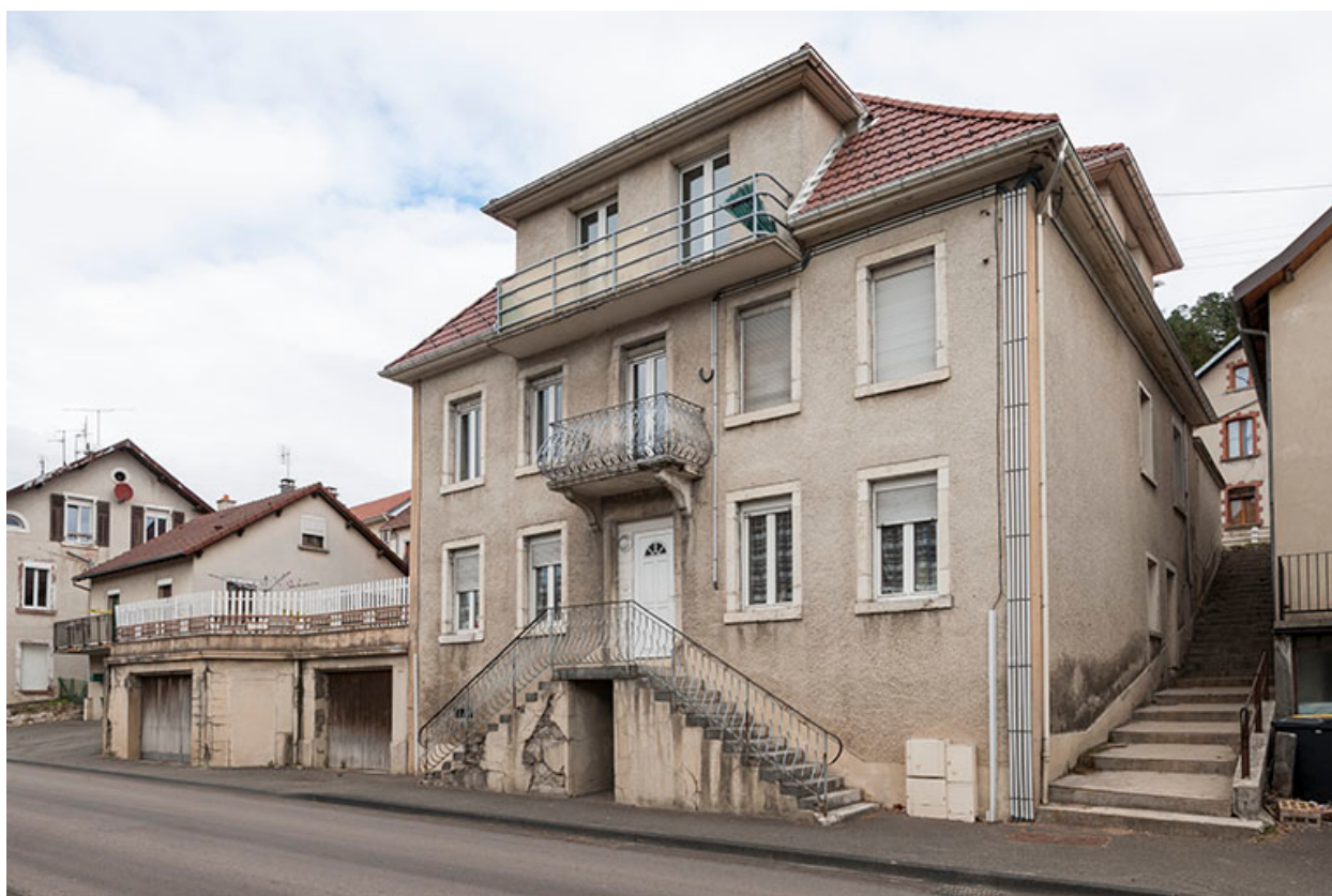
Maison : façades antérieure et latérale droite.
