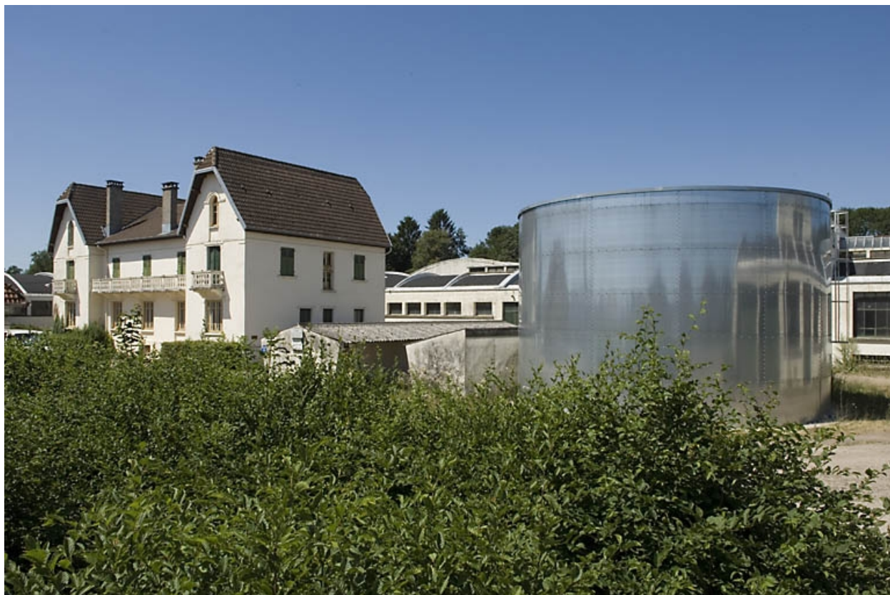
Le bâtiment des bureaux depuis le sud-est.
