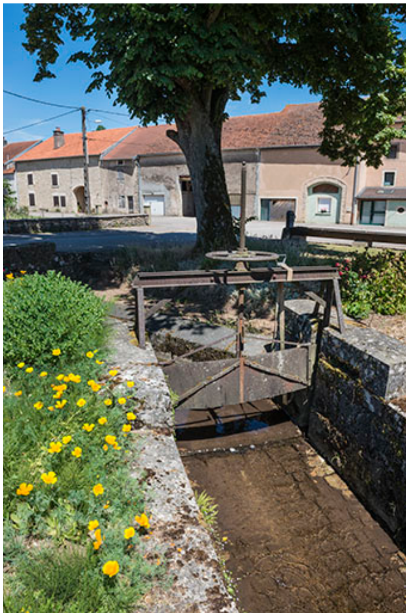
Vanne située à l'extrémité sud du village.
