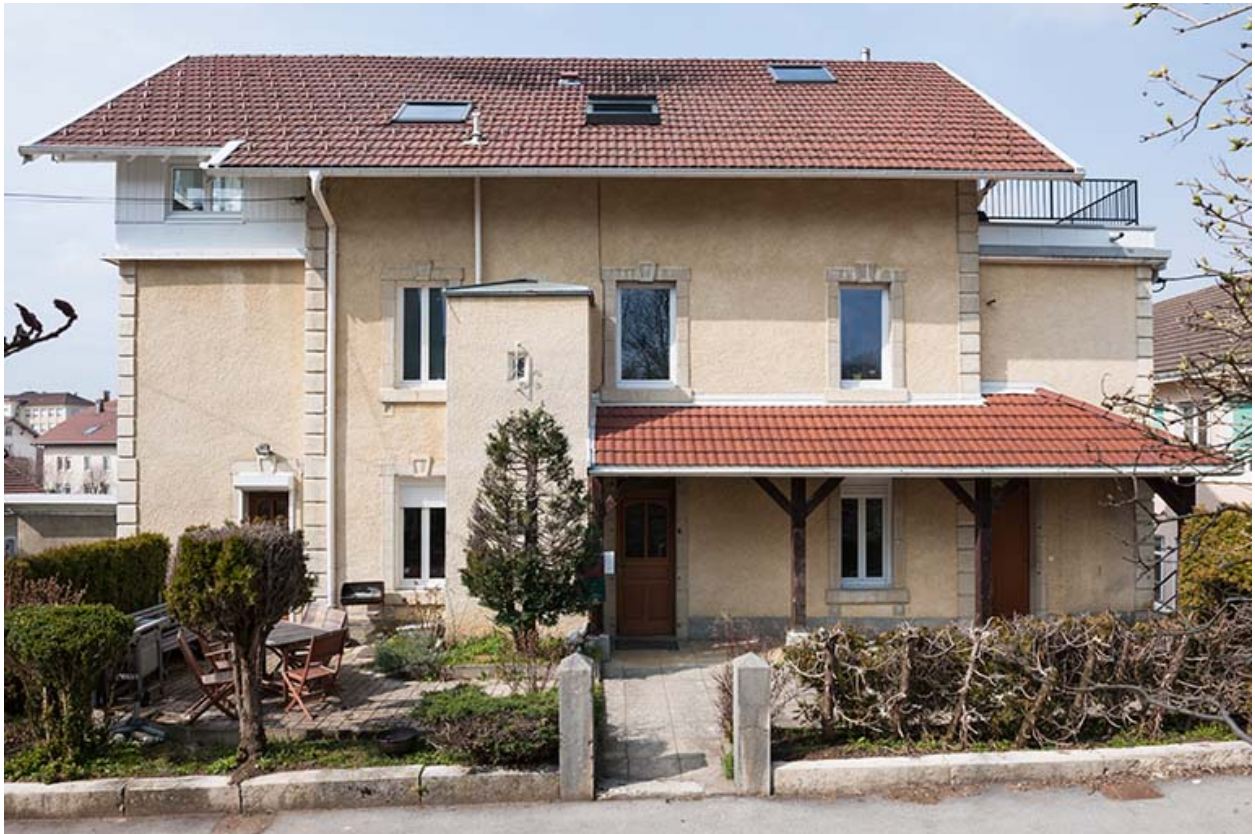
Maison : façade antérieure.
