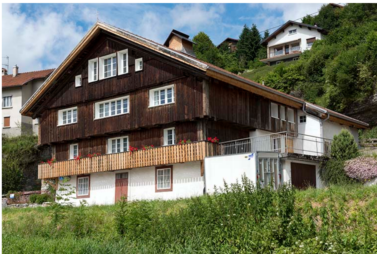
Façades antérieure et latérale droite.
