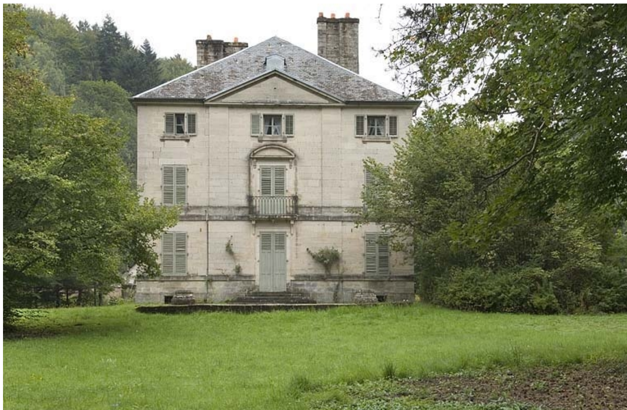
Façade sud de la demeure.
