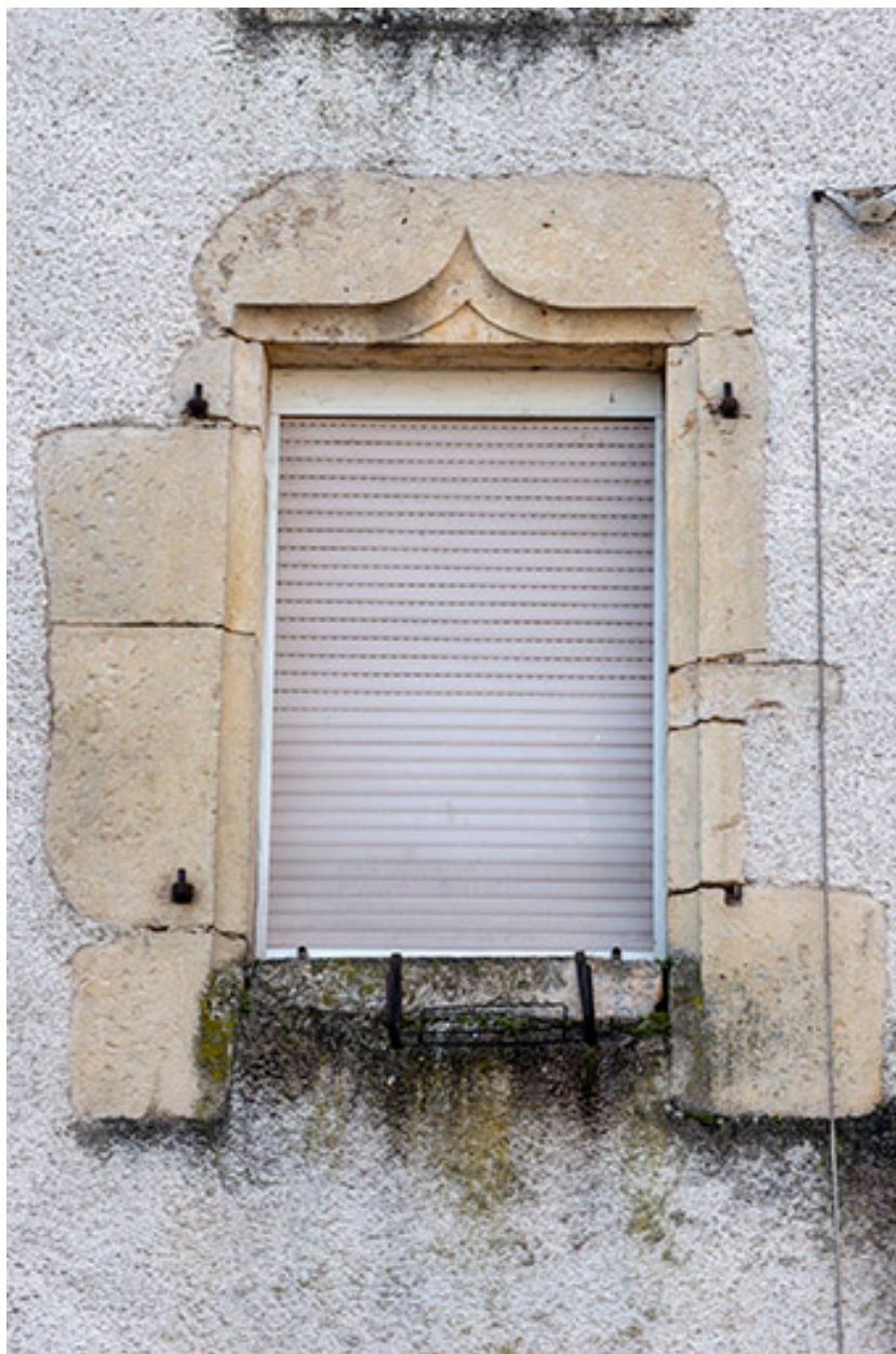
Fenêtre avec linteau en accolade.
