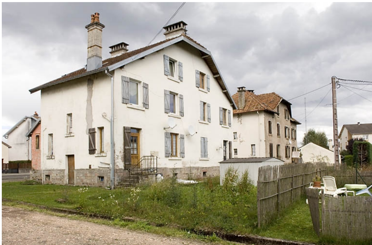
Façades postérieures des maisons ouvrières.
