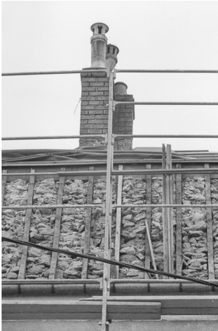
Réfection de la toiture.
