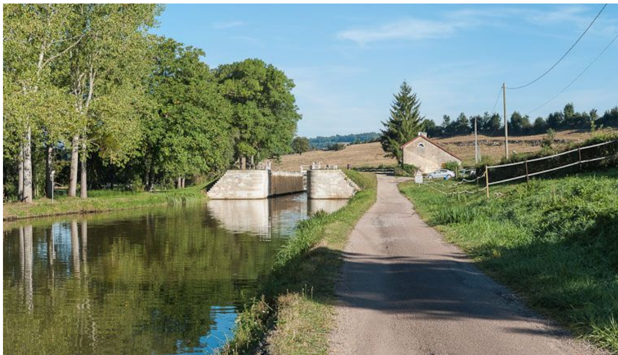
Vue du sas d'écluse depuis l'aval.
