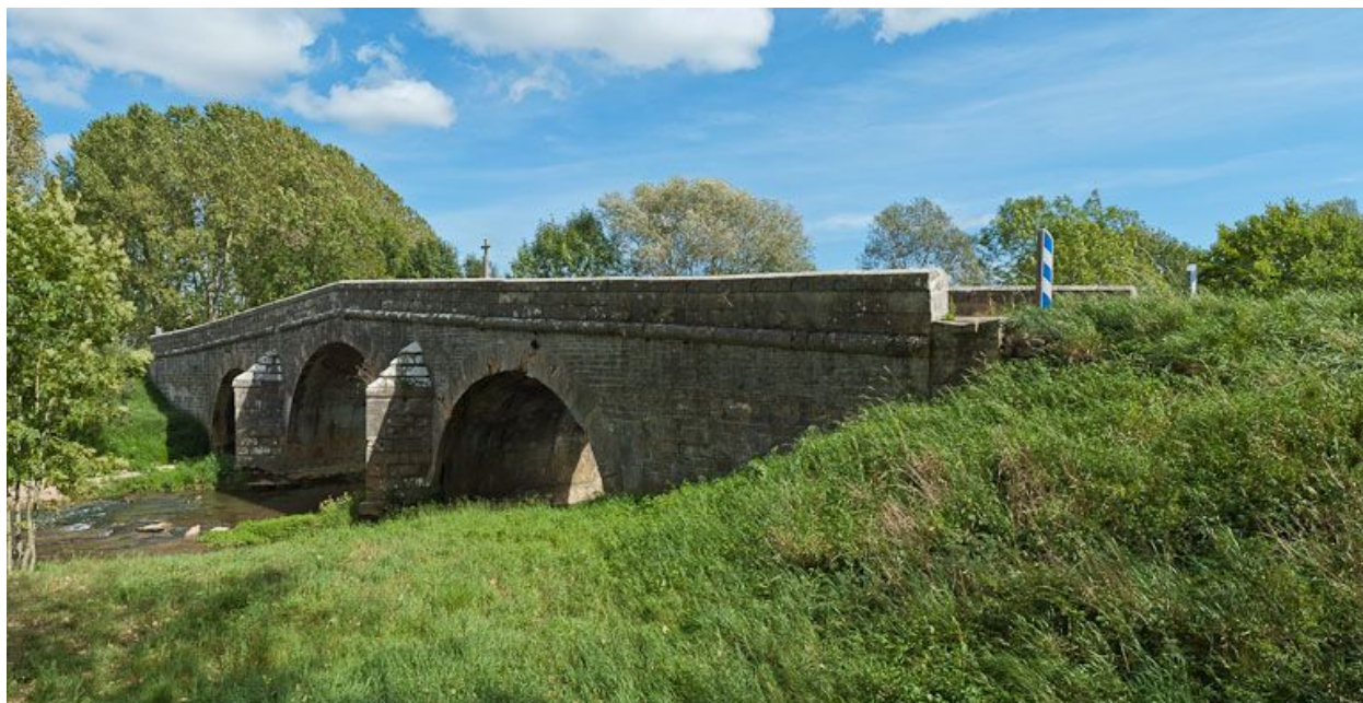
Vue du pont.
