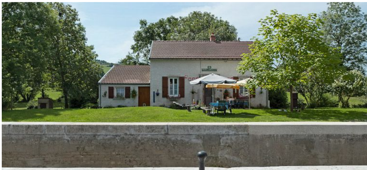
Vue de face de la maison éclusière.
