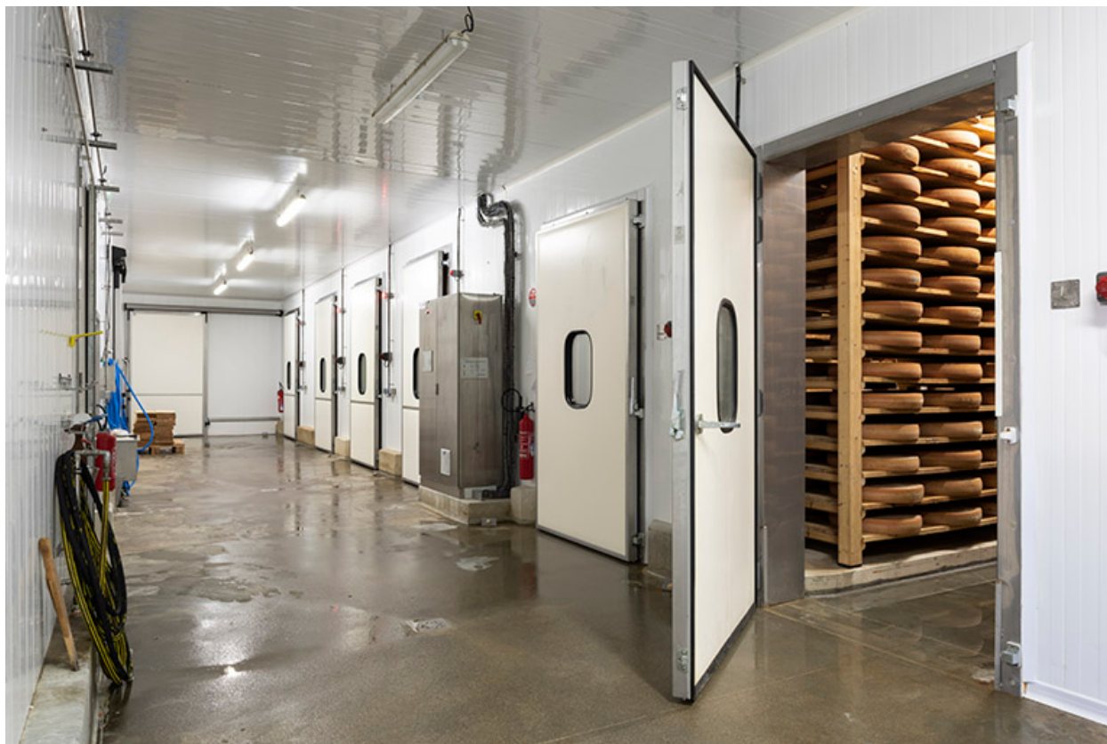
Cave d'affinage : couloir desservant les pièces.
