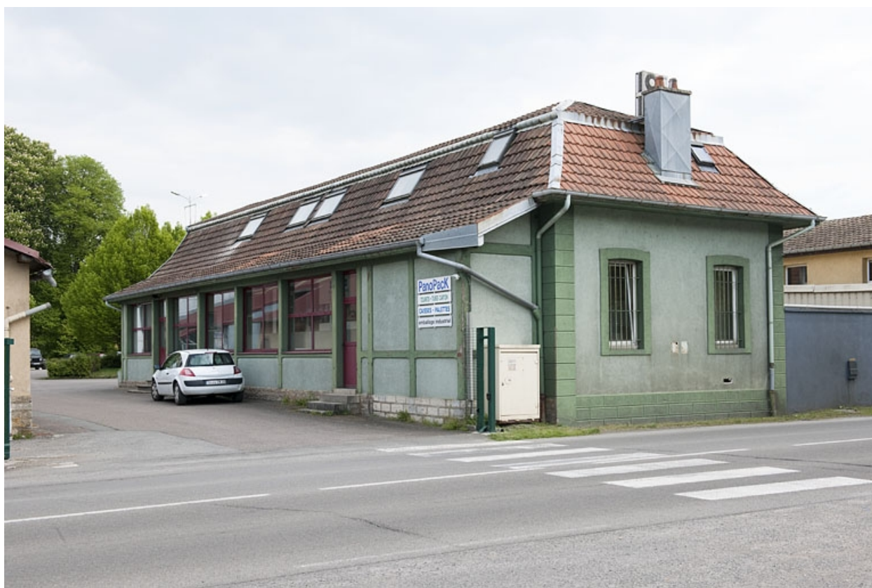
Entrée du site. Les bureaux.
