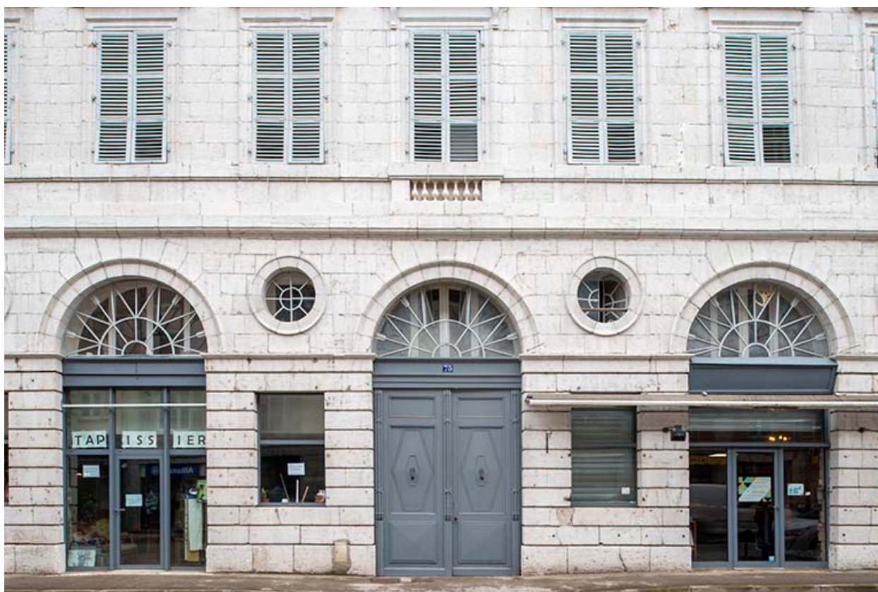
Travées centrales du rez-de-chaussée.
