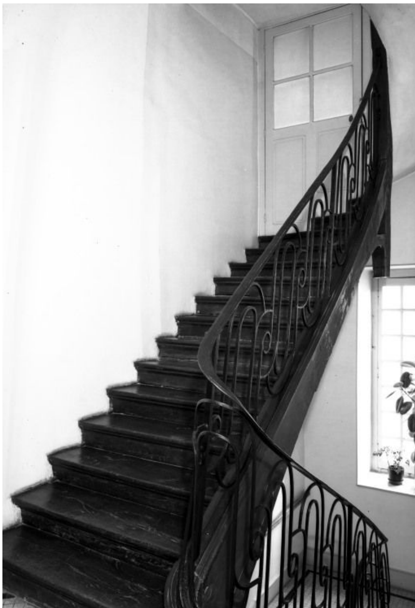
Escalier, volée menant au comble.
