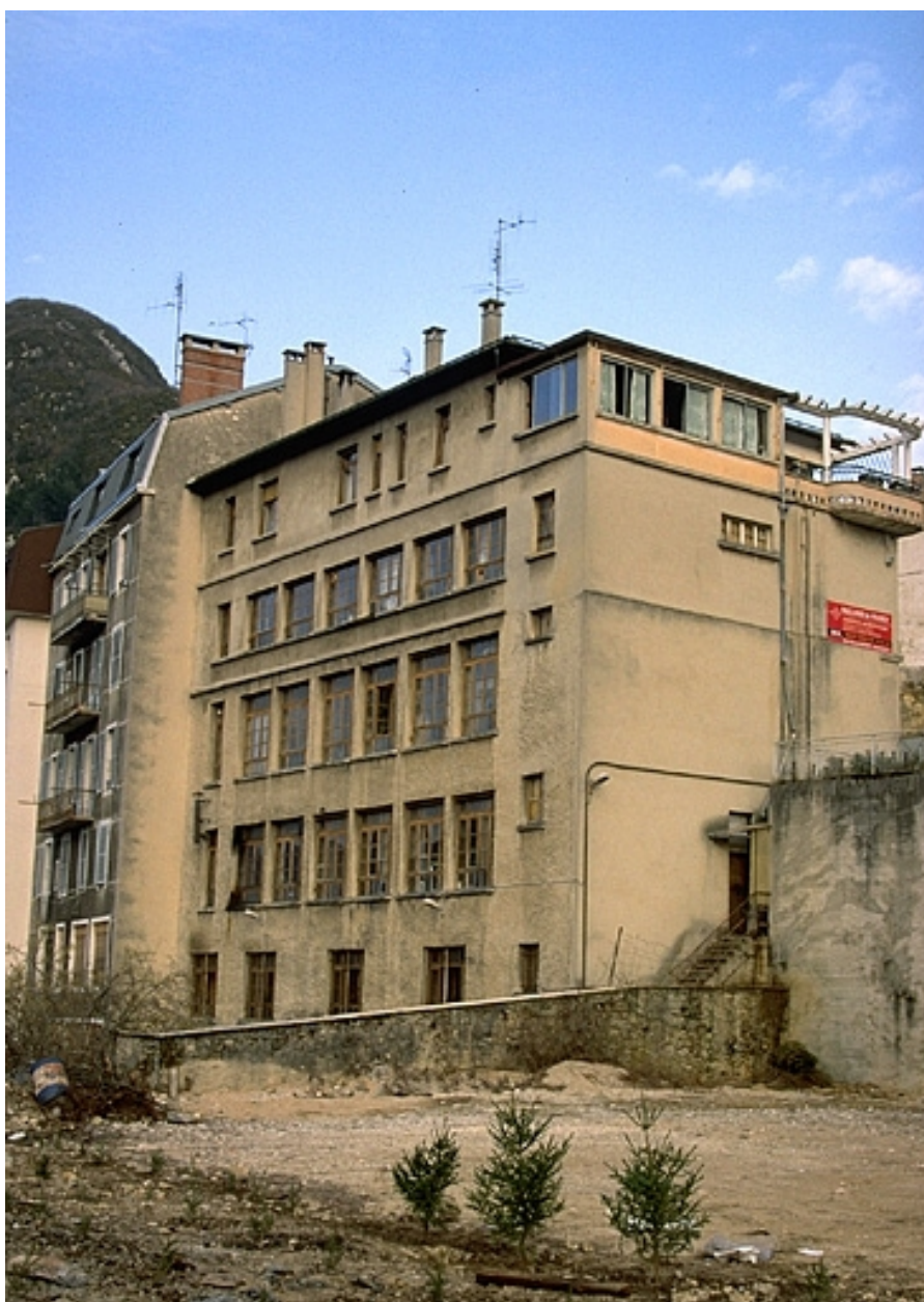
Façades postérieure et latérale gauche.
