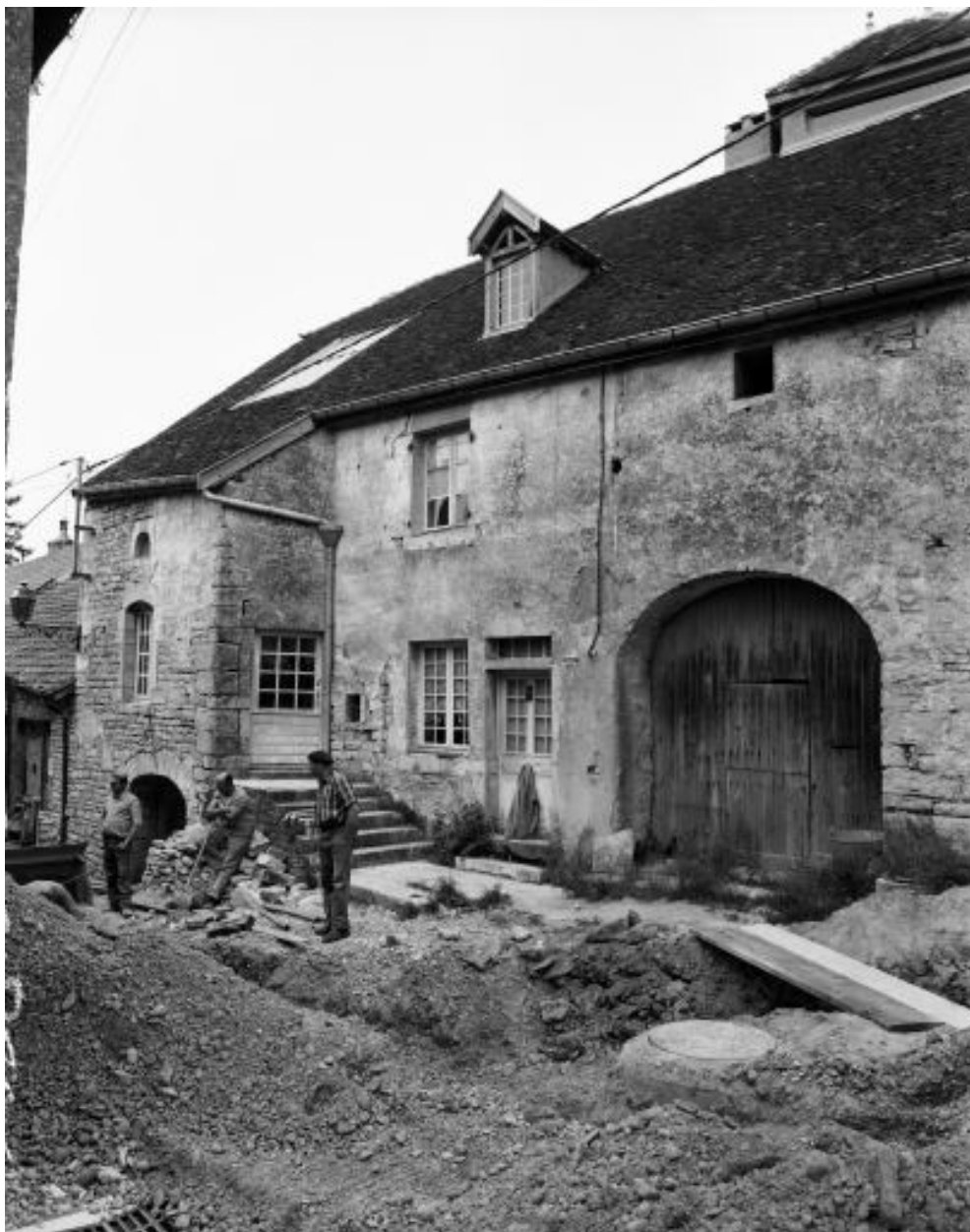
Façade antérieure, partie gauche.
