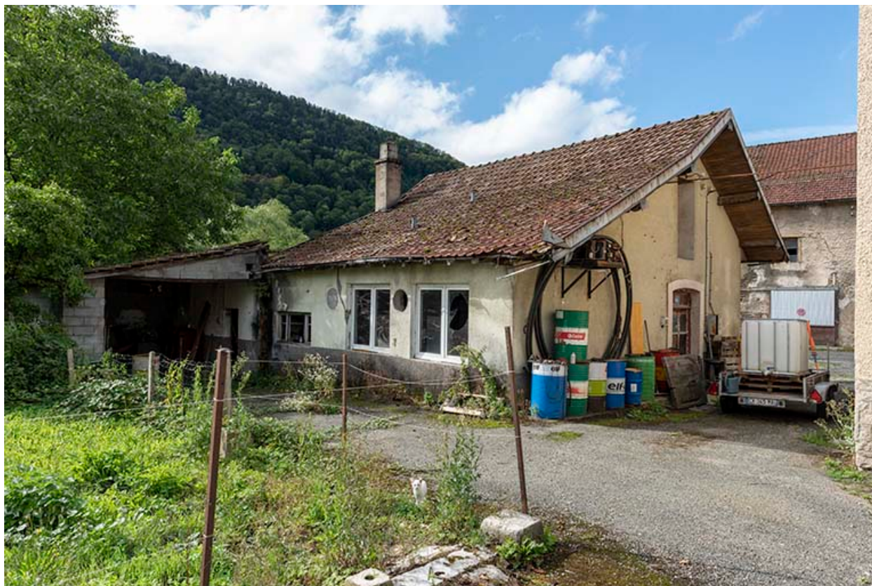
Façades antérieure et latérale gauche.
