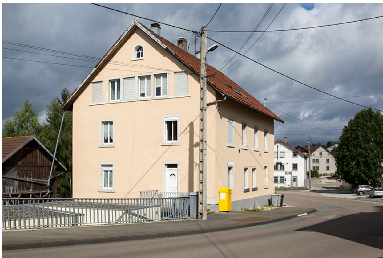
Façades postérieure et latérale droite.
