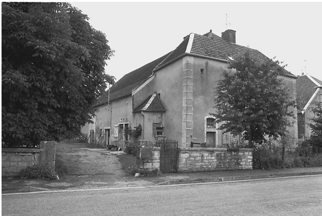
Vue du bâtiment de trois quarts gauche.
