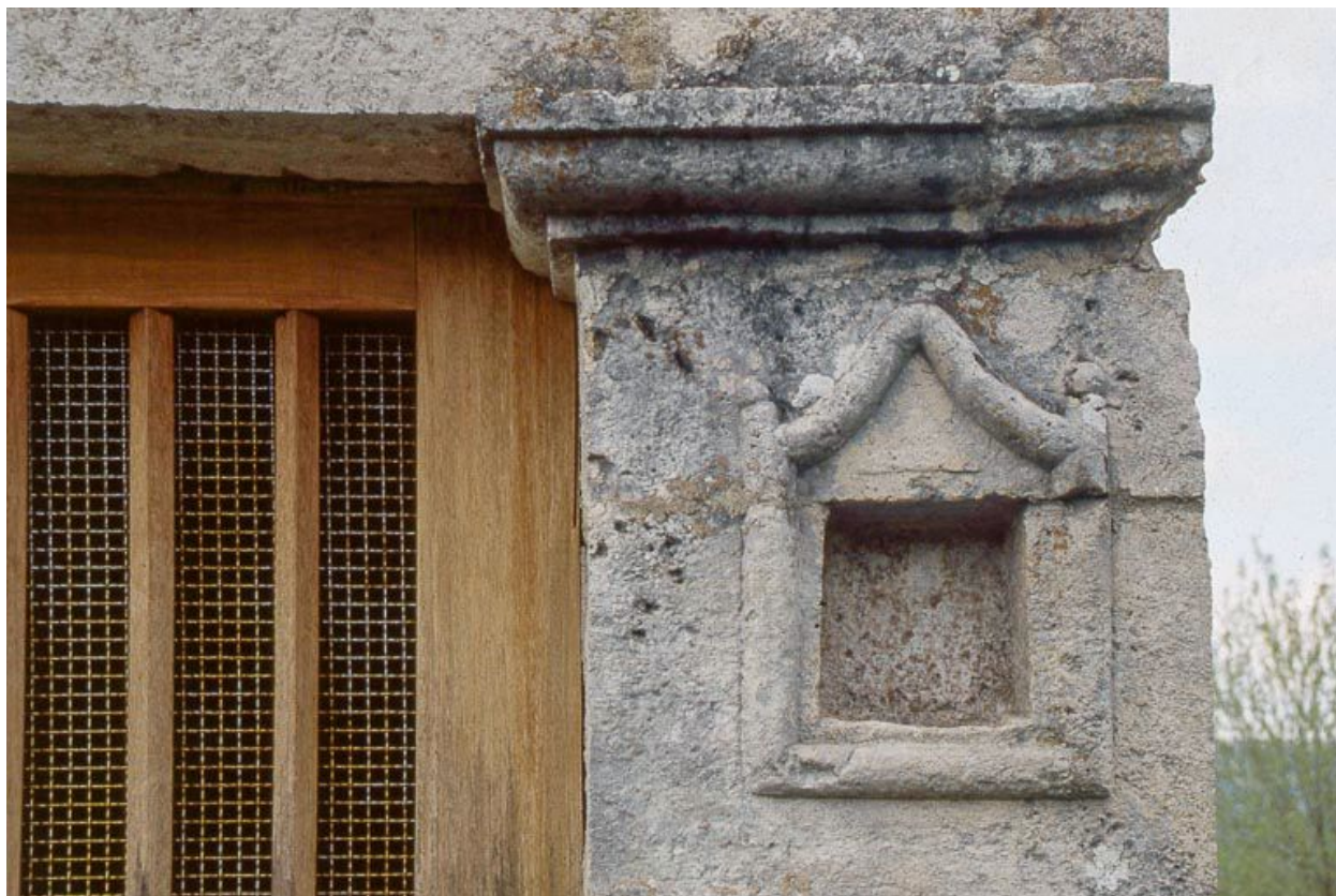
La niche du piédroit de la porte.
