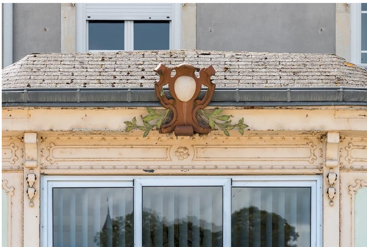
Aile ouest, salle à manger, détail.
