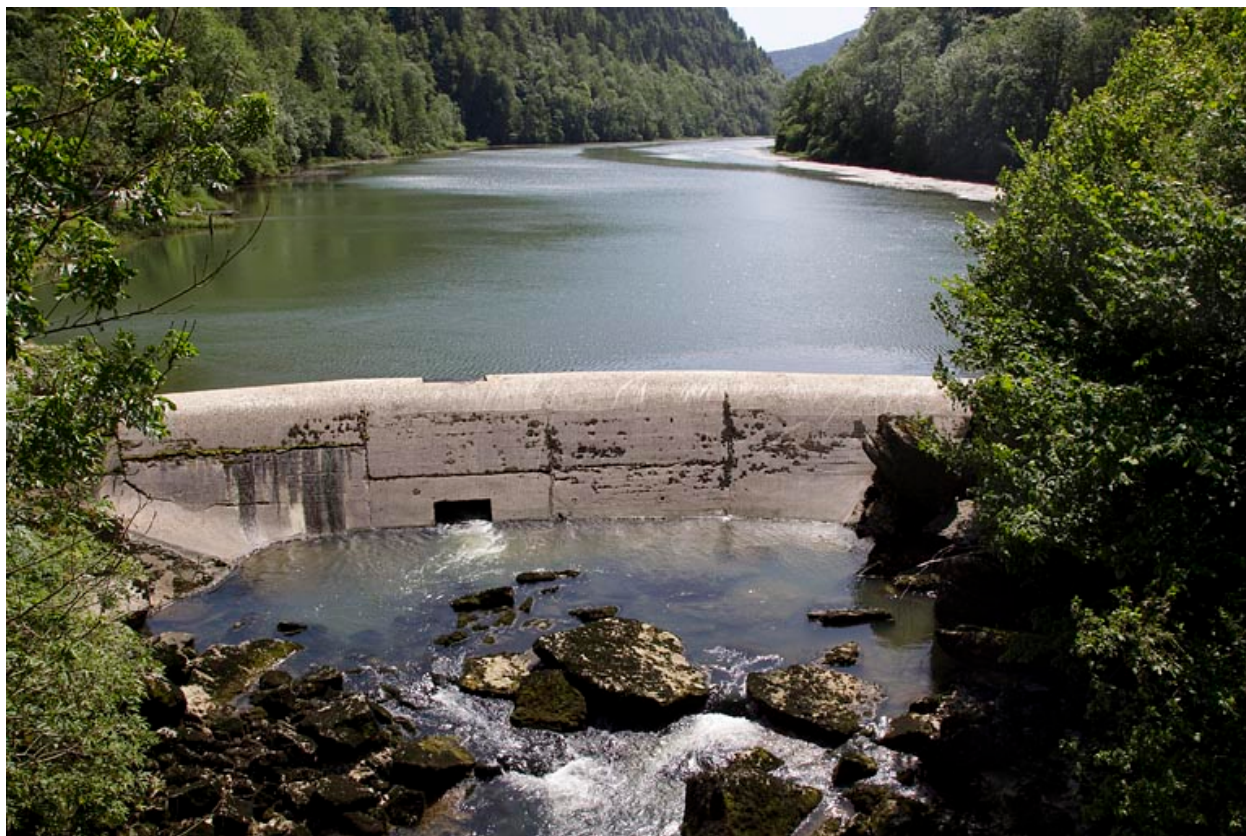
Barrage de la Goule : face aval.
