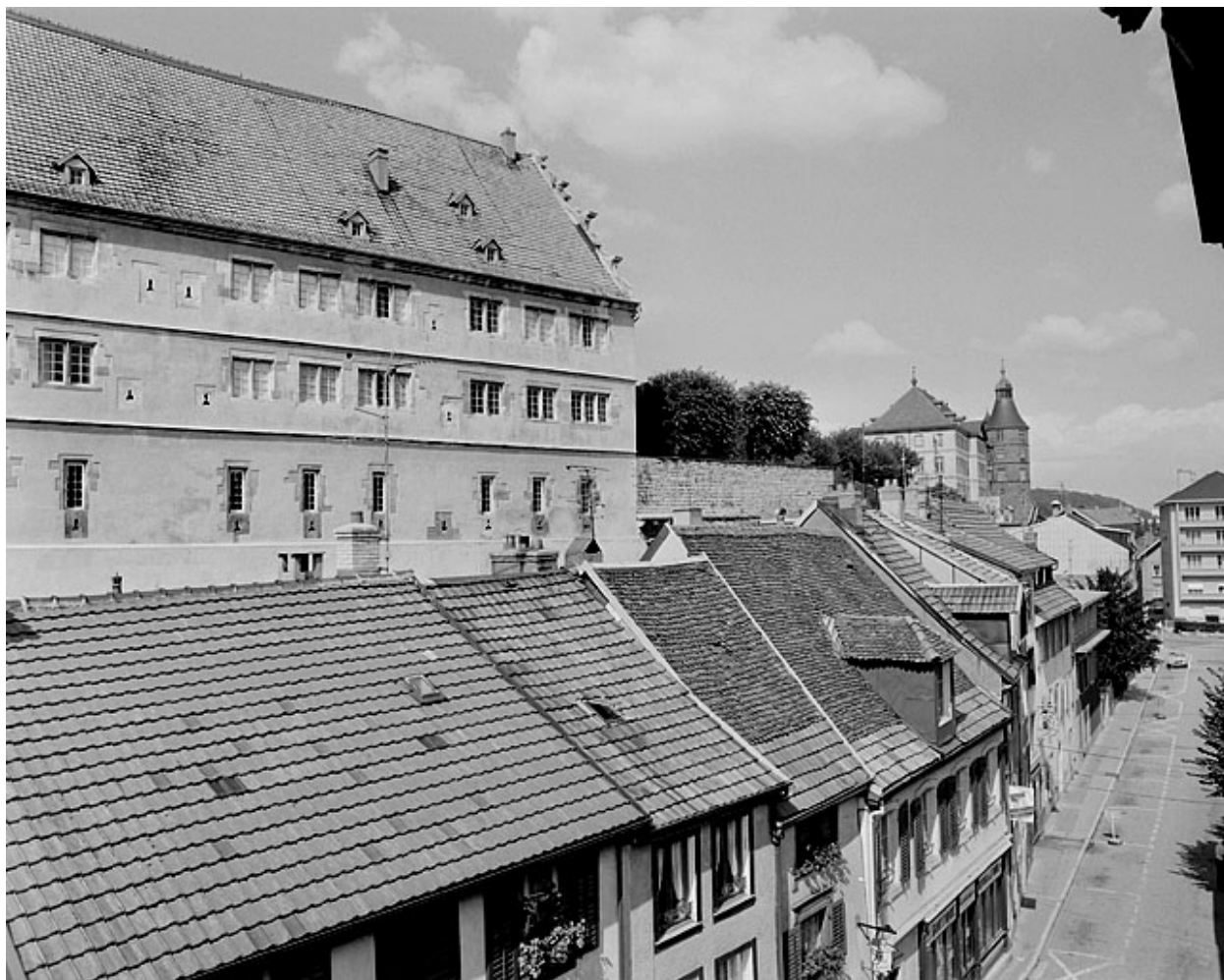
Façade sud et rue de Belfort.
