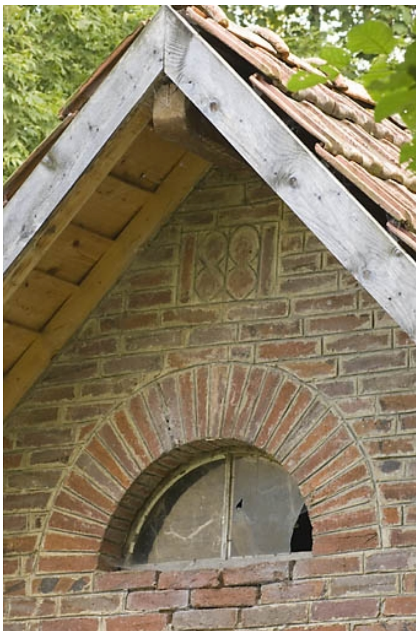
Remise : fenêtre et date.
