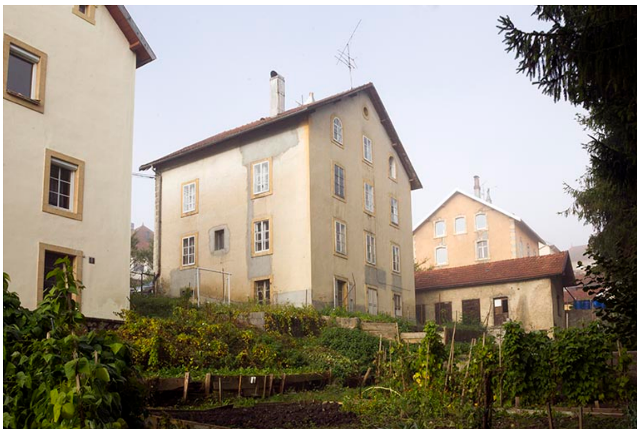
Façades postérieure et latérale droite.
