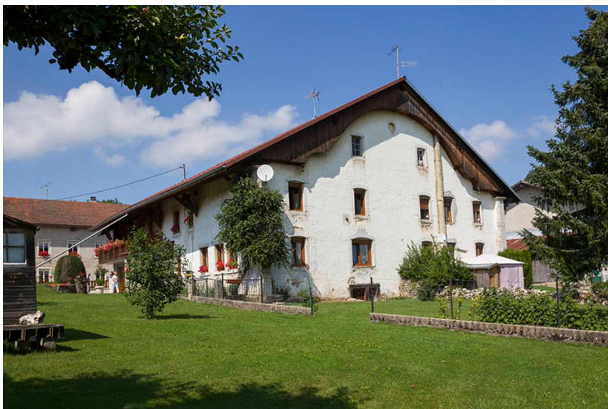
Façades sud et est.
