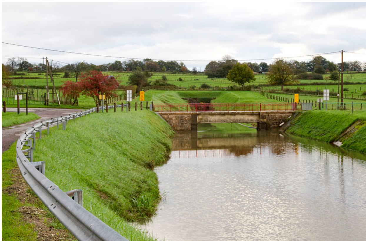
Bief d'amenée à la sortie du tunnel.
