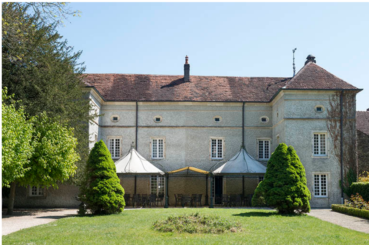
La façade postérieure.
