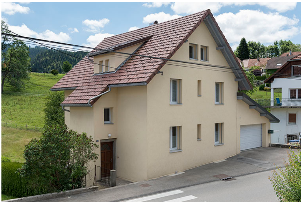
Façades antérieure et latérale gauche.
