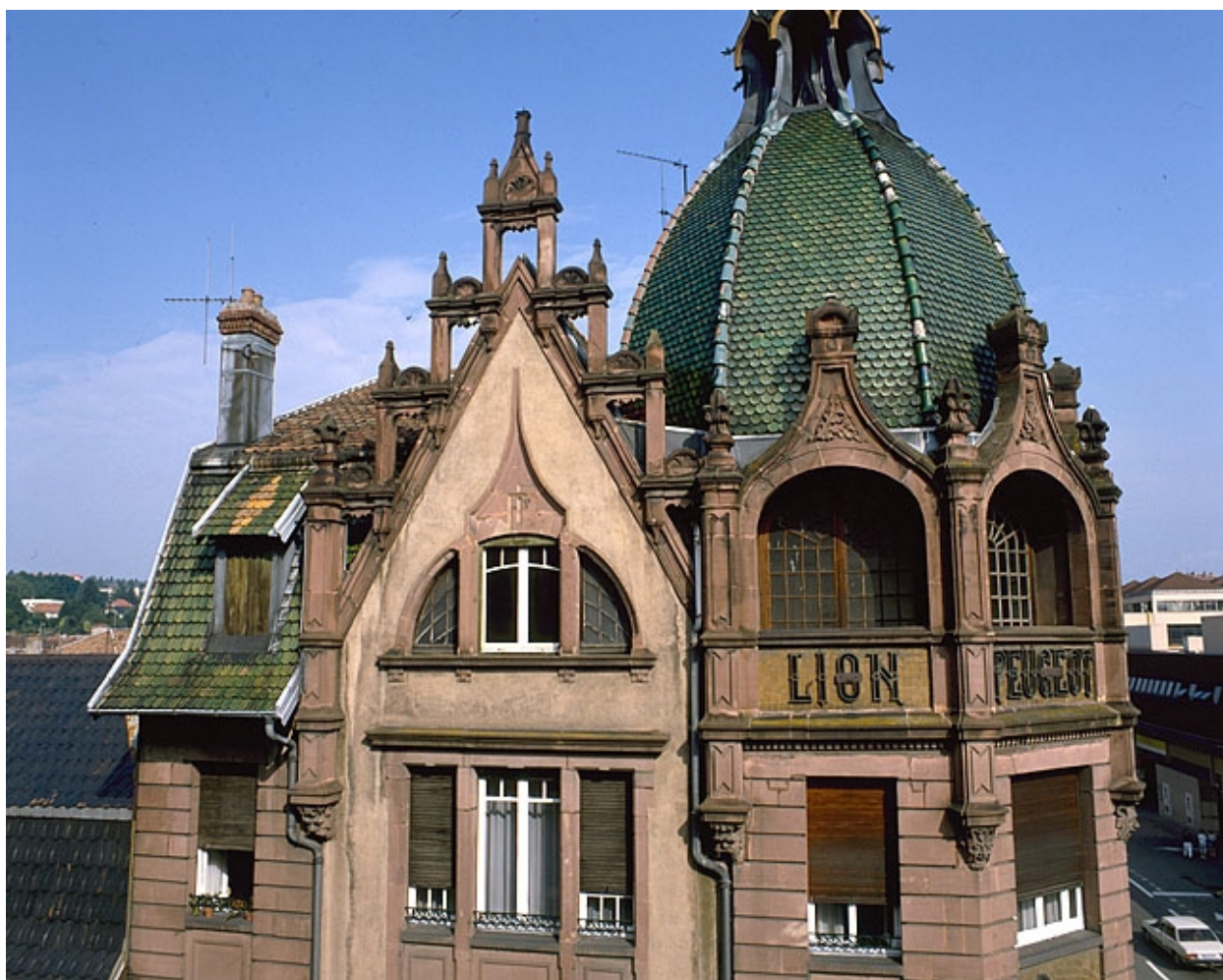
Ensemble des parties hautes, côté rue Cuvier.
